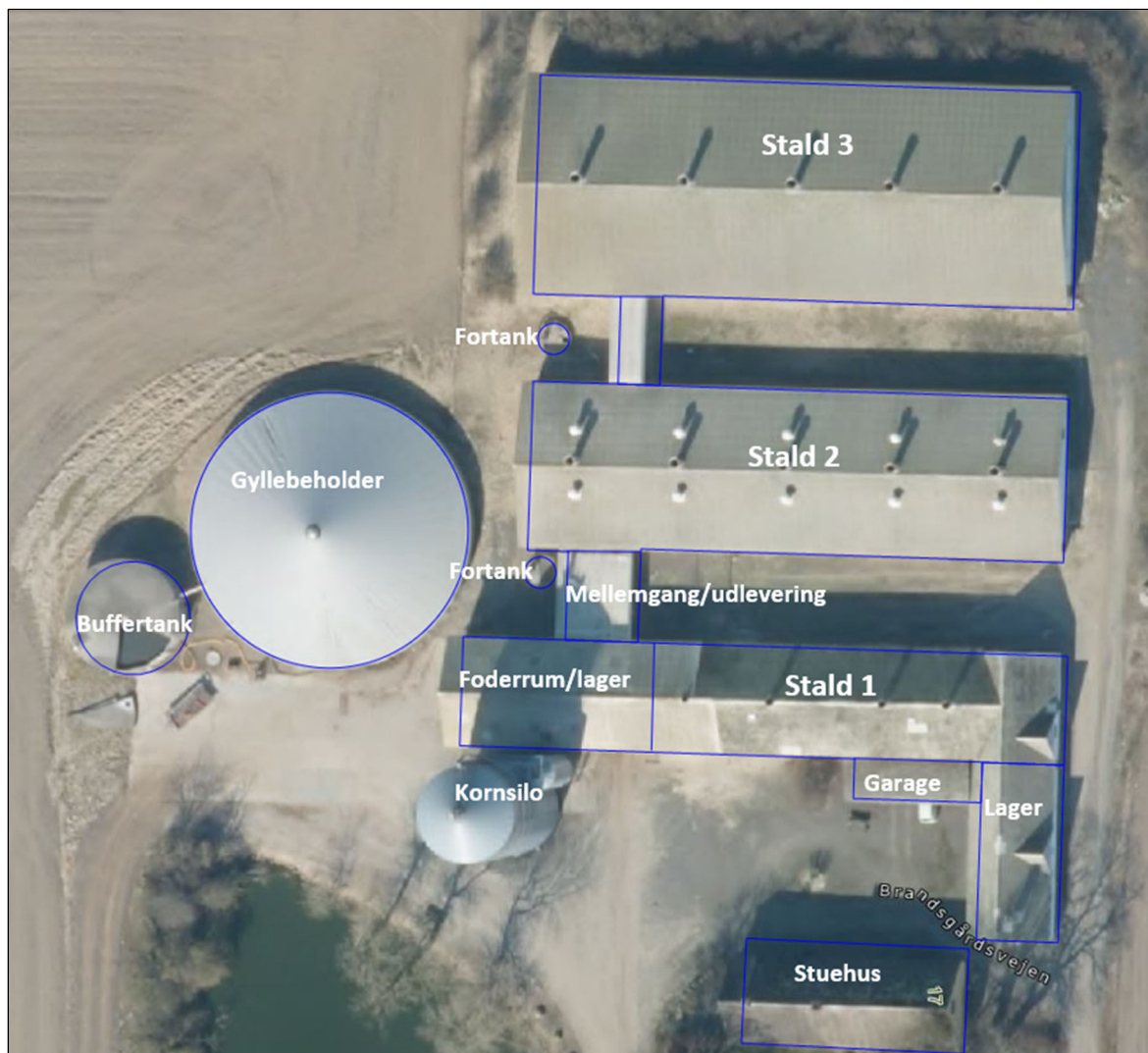
Figur 1a. Eksisterende bygningsanlæg på Nørregård.
