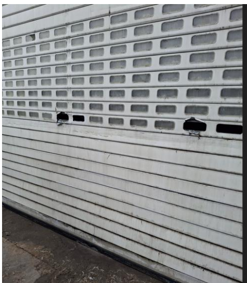
Billede 9. Hullet port.
