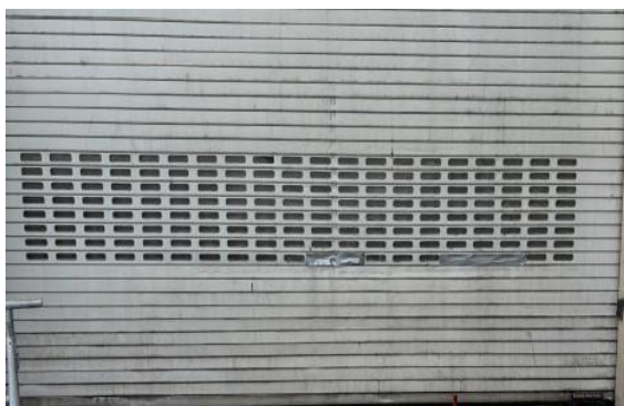
Billede 10. Midlertidig repareret port (Billede fra Farmfood).
