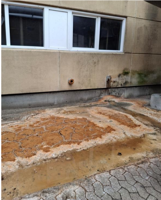
Billed 5. Lag/svamp på kondensat.
