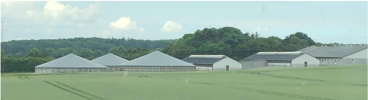
Figur 6 Egeløkke med nymonterede telttage på gyllebeholdere.
