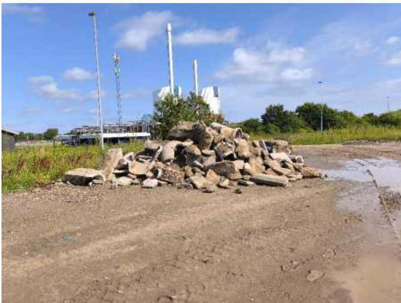
Betonoplæg på pladsen fjernes til godkendt modtager.
