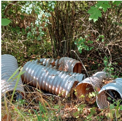
Plastrør ved perkolattanke
