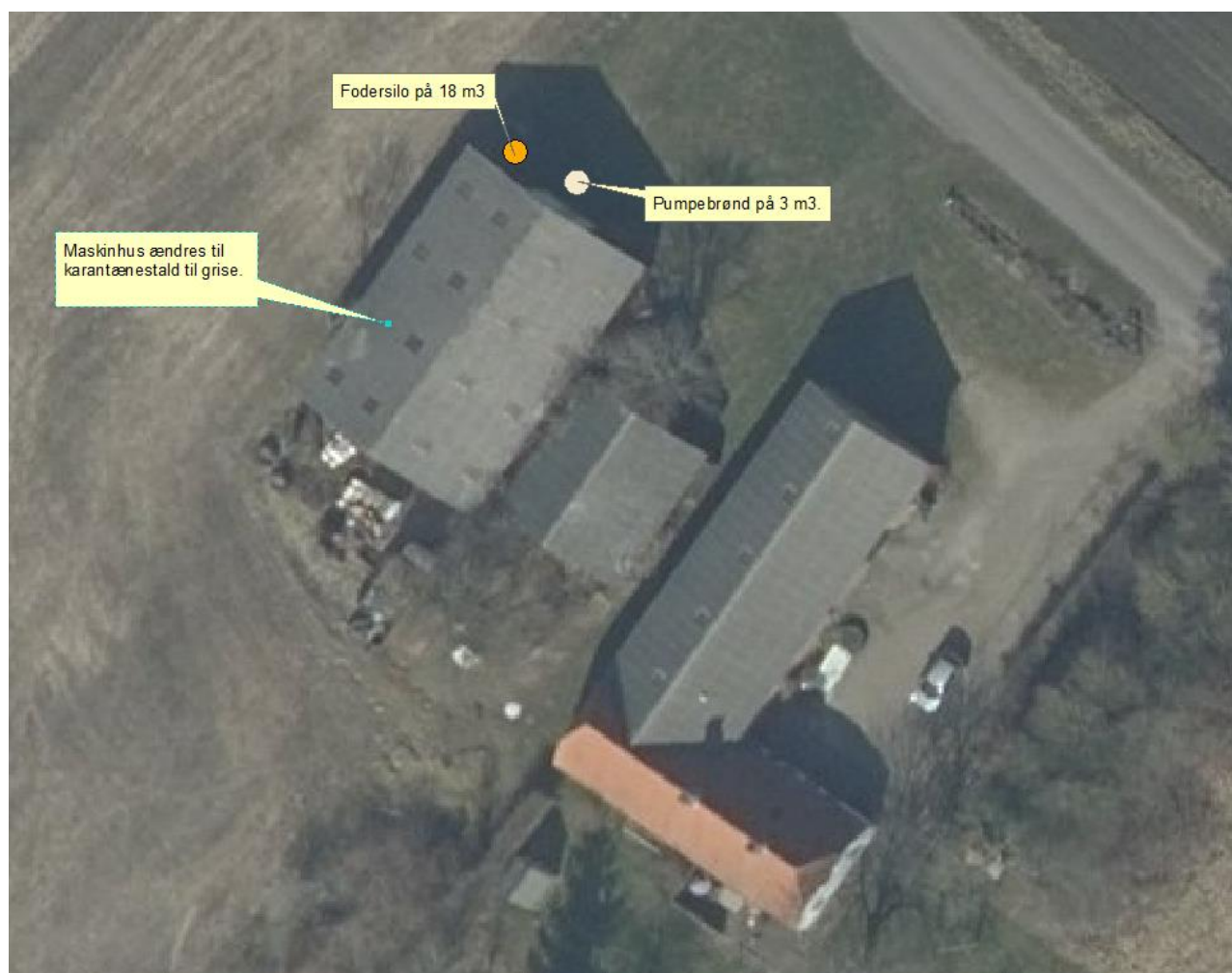
Figur 2. Oversigt over husdyrbrugets bygninger.
