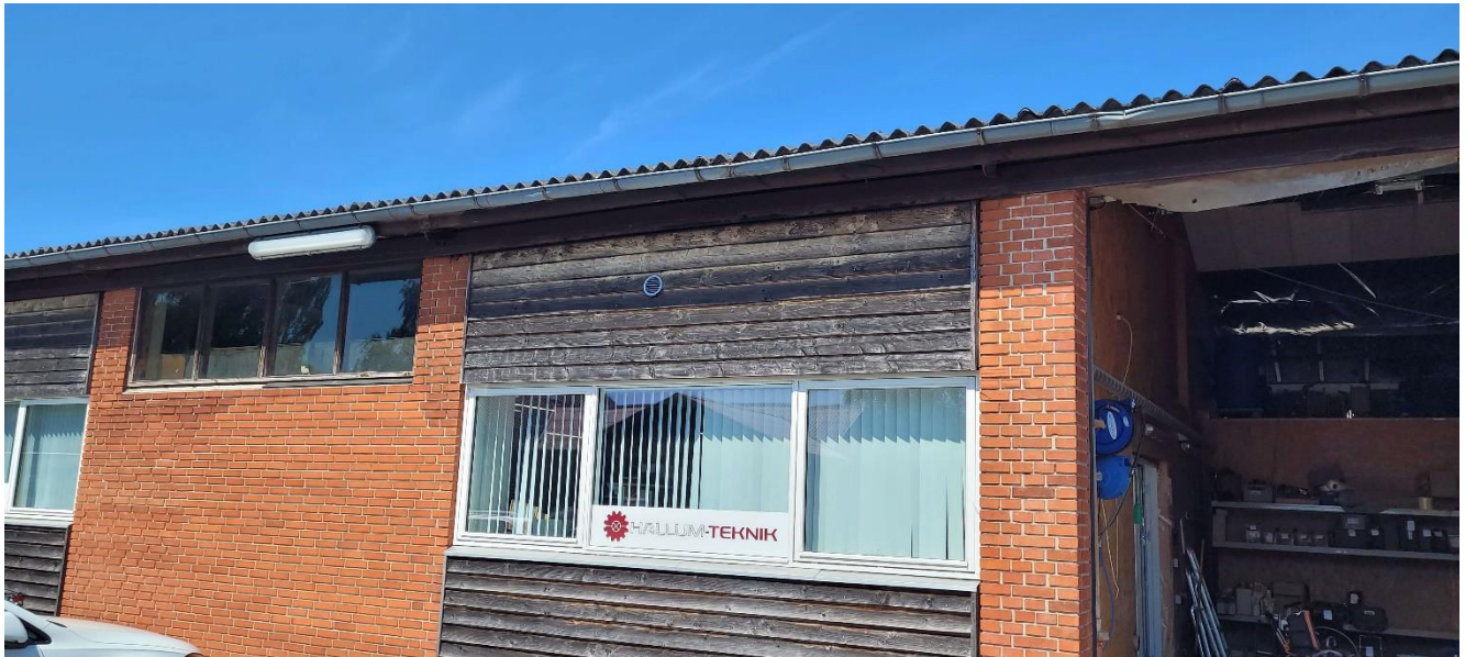
Udsugningsafkast i facade.
