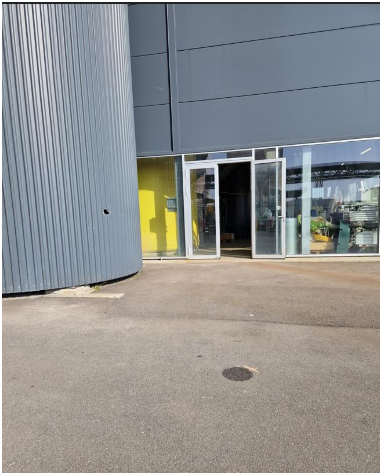
Figur 8-5 Boring ved målested N4 – Restproduktsilo for affaldslinjer
