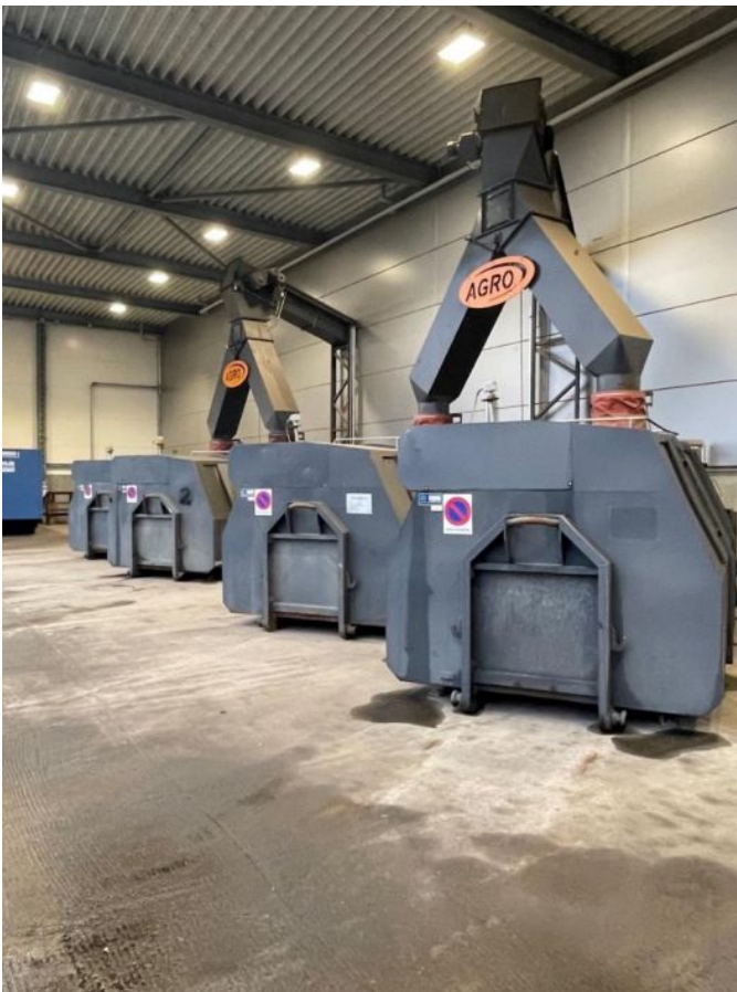
Figur 3-13 Slagge- og askehåndtering fra fliskedler
