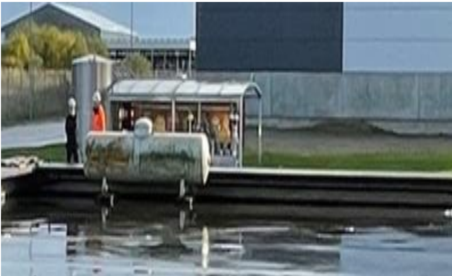
Figur 3-10 Propangastank i spejlbassin nord
