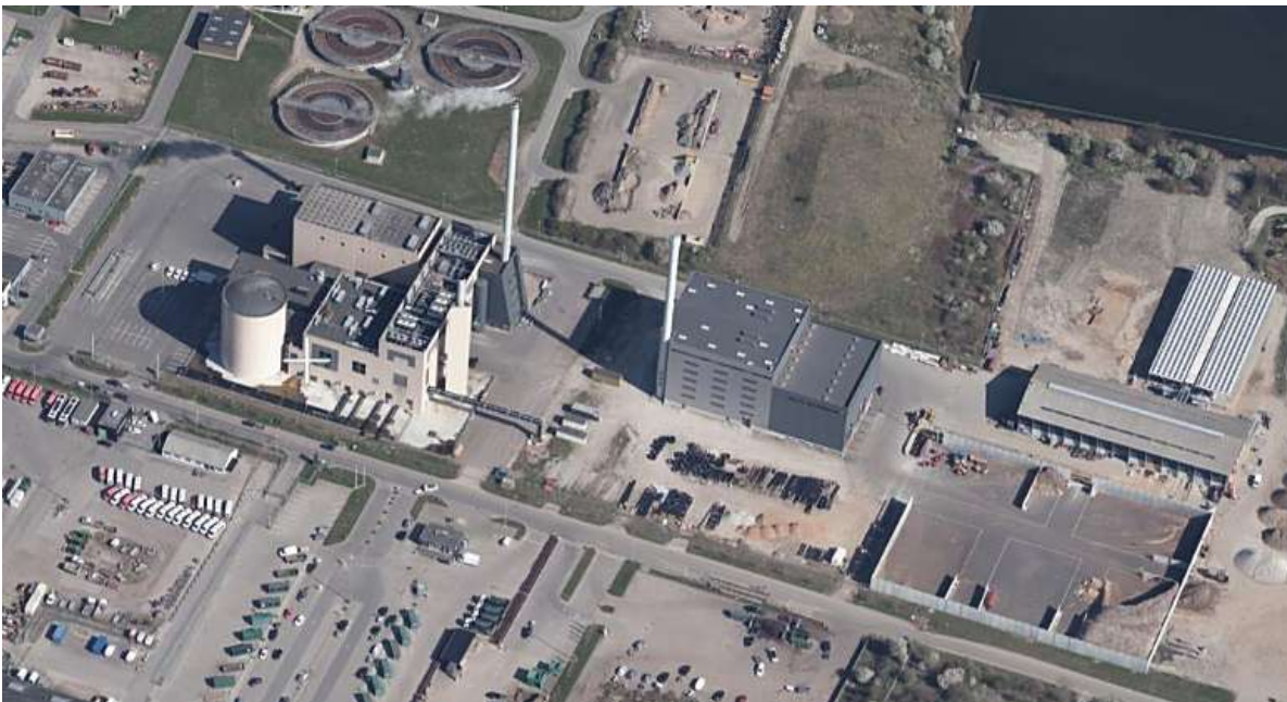
Figur 5-2 Anlægget på Endelavevej efter opførelse af varmepumpeanlæg 2021 (Skråfoto 12 )
