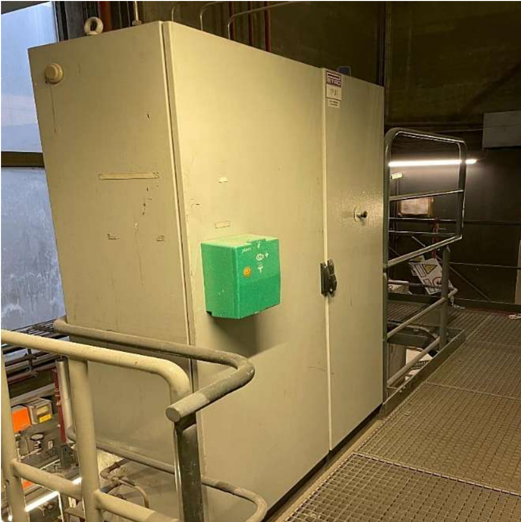
Figur 3-2 SNCR-unit til affaldskedler til styring og fordeling af ammoniakvand
