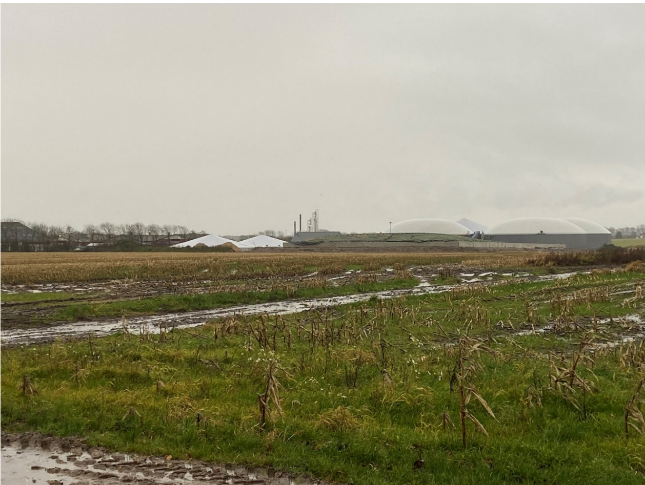
Fotostandpunkt nr. 1, Hjeddingvej 7 (Etableret anlæg)
