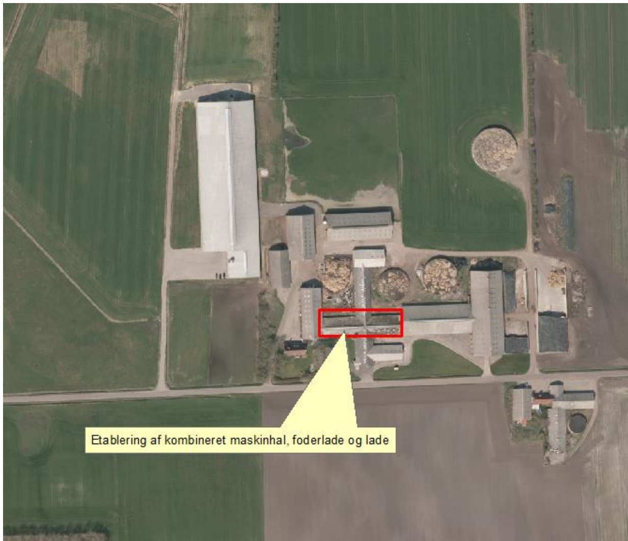
Kort 1: Oversigt over maskinhus og eksisterende bygninger på Hølleskovvej 54.
