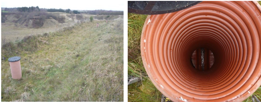
Figur 12 Inspektionsbrønde (til drænrør) placeret langs skrænten mod nord (TV). Kig ned i inspektionsbrønd med rindende drænvand (TH).
