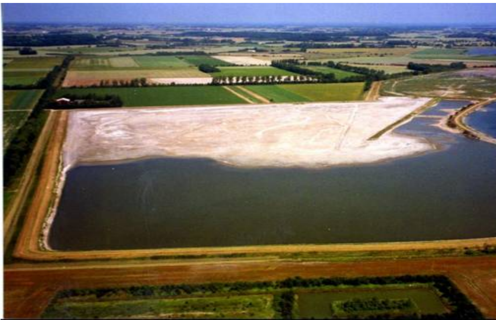
Foto af spulefeltet 2. juli 1993 umiddelbart efter den første større indspuling på 179.600 m 3 sediment er afsluttet i 1992.
