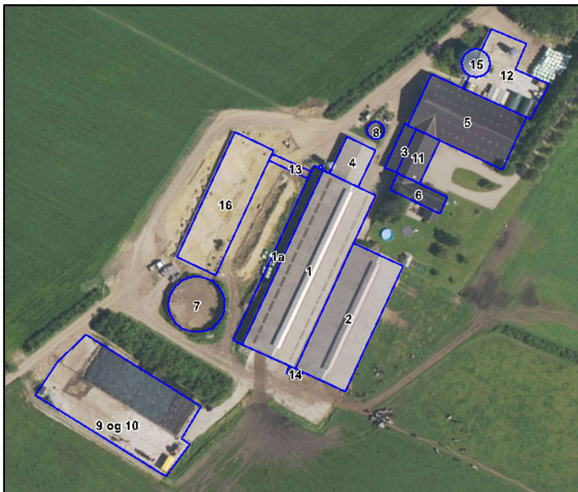
Figur 1. Oversigt over husdyrbrugets bygninger.
