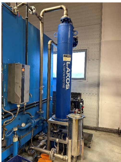
Billede nr. 7: Filter på stor vaskemaskine (2024) Billede nr. 8: Opsamling af afskimmet olie (2024)
