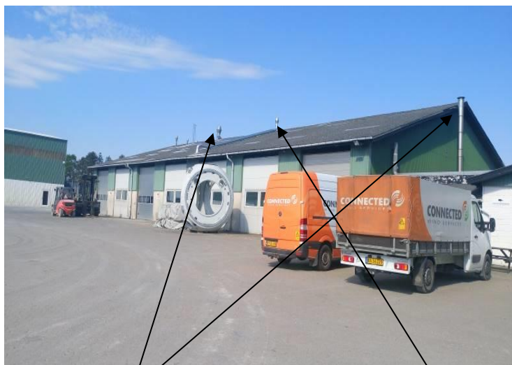
Billede nr. 2: Afkast 1 (Punktudsugning - slibning), Afkast 14 (ny stor vaskemaskine), Afkast 10 (anvendes ikke) (2018)
