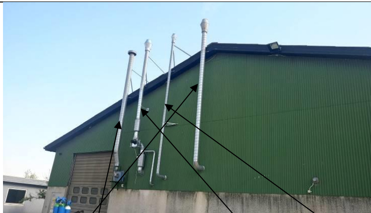
Billede nr. 1: Afkast 2 (punktudsug), Afkast 3 (boltvasker), Afkast 4 (Anvendes ikke), Afkast 5 (vaskemaskine) (2018). Der er nu etableret en overdækket plads for enden af bygningen (2024).
