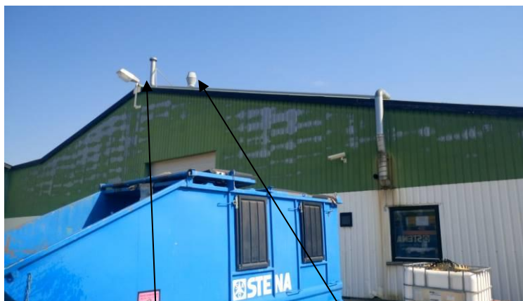
Billede nr. 3: Afkast 7 (vaskemaskine), Afkast 8 (højtryksudsug (kW + MW-værksted) (2018)
