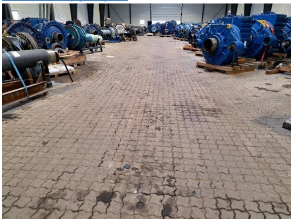
Billede nr. 26: Oliespild på belægningssten
