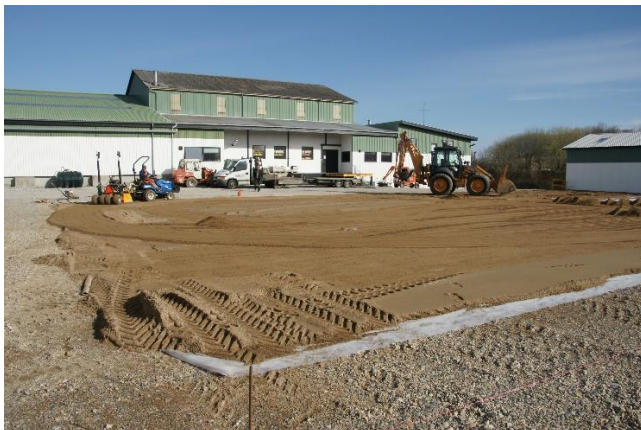
Billede nr. 29: Billede modtaget fra virksomheden, som er taget ifm. etablering af bygning 14 i 2021.
