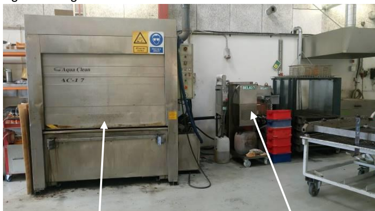
Billede nr. 9: Vaskemaskine i kW-gearværksted. Båndfilter til vaskemaskinen (2018)
