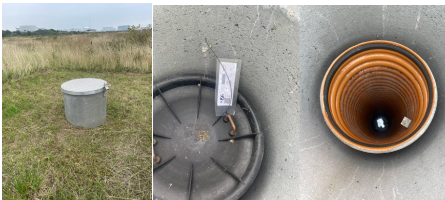
Brønd 6 med afmærkning og synlig perkolatstand
