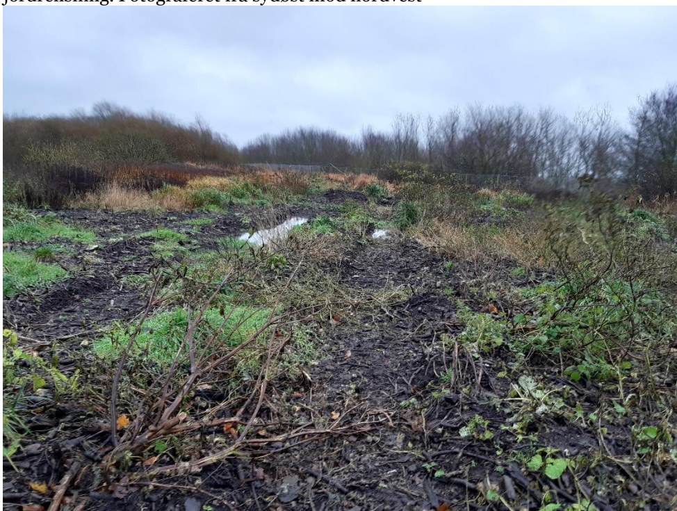
Figur 13: Overflade på den sydlige del af etape 3, hvor der er kørespor i slutafdækningen.
