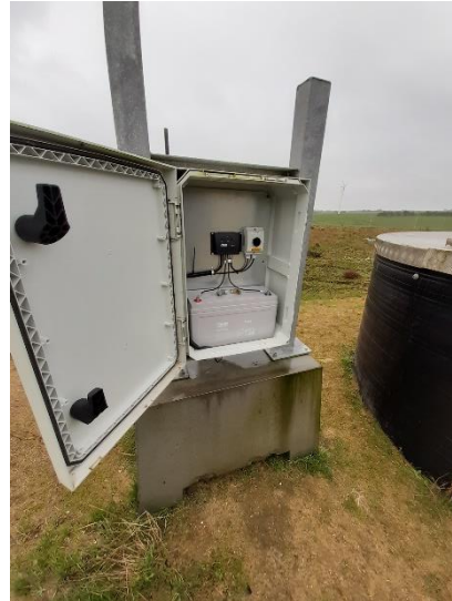
Figur 5: Flowmålerskab med solceller (monteret på stang ovenfor skab) og batteri.
