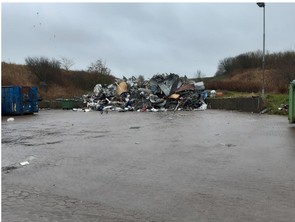
Figur 8: Oplag af metalskrrot, der er skubbet op, så det ligger delvis udenfor befæstet areal. Opkørsel til deponi/adgangsvej til komprimatorstation ses til højre i billedet.
