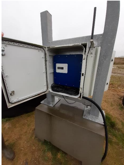
Figur 5: Flowmålerskab med solceller (monteret på stang ovenfor skab) og batteri.
