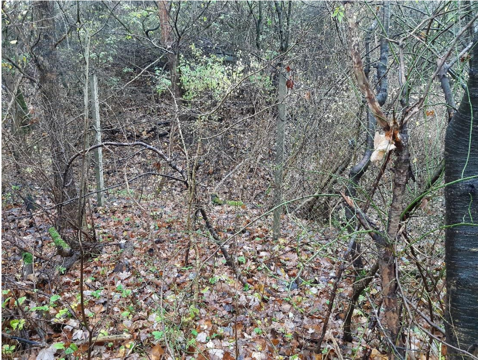
Figur 4: Foto af defekt hegn tæt ved det nordøstlige hjørne af etape 1. Trådene er imellem de to stolper på fotoet rustet over, således der reelt kun er hegn op i ca. en halv meters højde.
