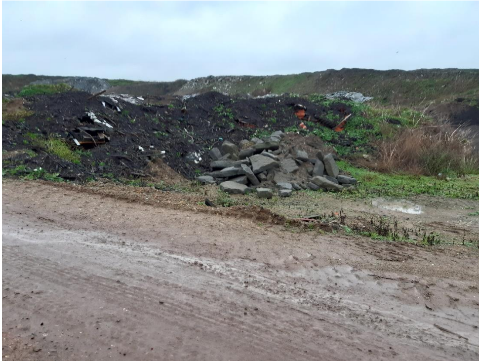
Figur 11: På enhed 10 sker der daglig afdækning af asbest med færdig kompost.
