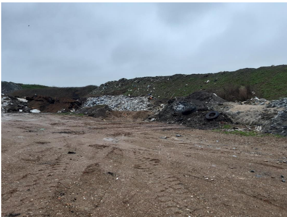
Figur 10: Adskillelse af affald deponeret på enhed 6 (blandet affald) og enhed 9 (mineralsk affald). Der kan ses et tyndt lag af muldjord/mineraljord op af skråningen oven for den lyse affaldsfraktion.
