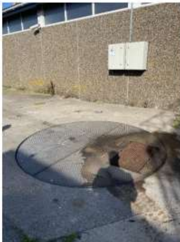
Figur 7 Opsamlingsbrønd 2 mellem hal 1 og tidl. produktionsbygning
