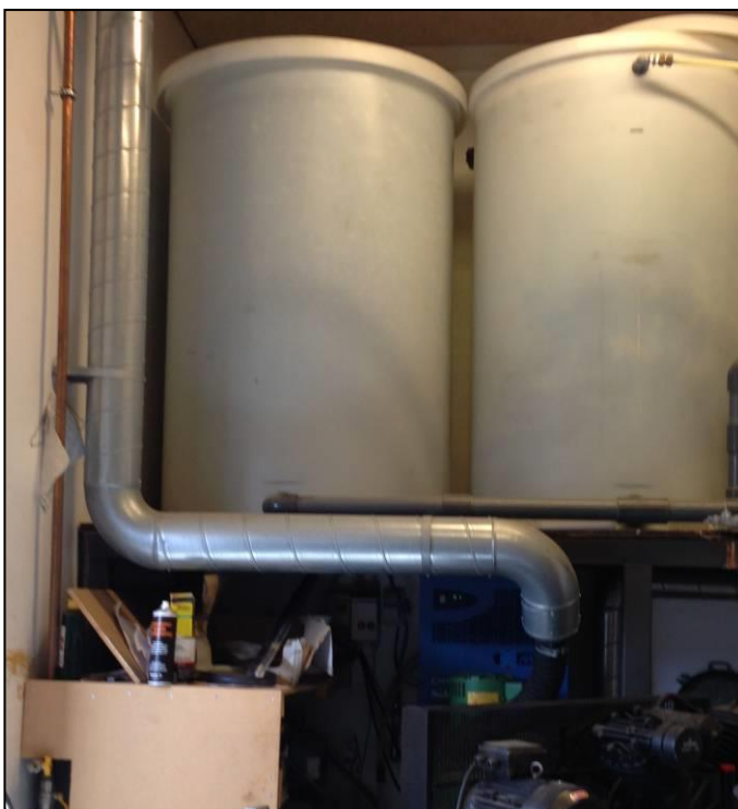
Beholdere til recirkulation af kølevand.
