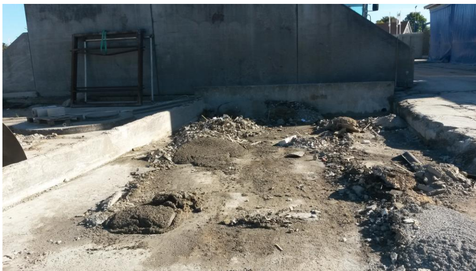
Oplag af betonrester
