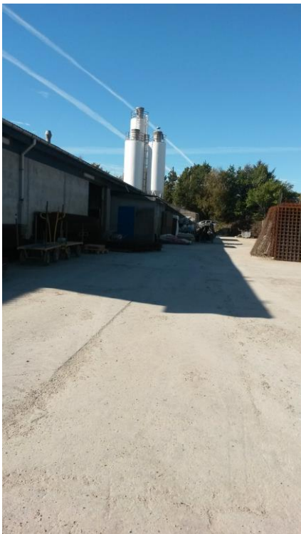
Cyklon og filtre på cement siloer
