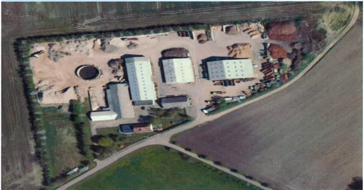
Laasholdt Entreprenør ApS, Hjertingskov Modtageranlæg
