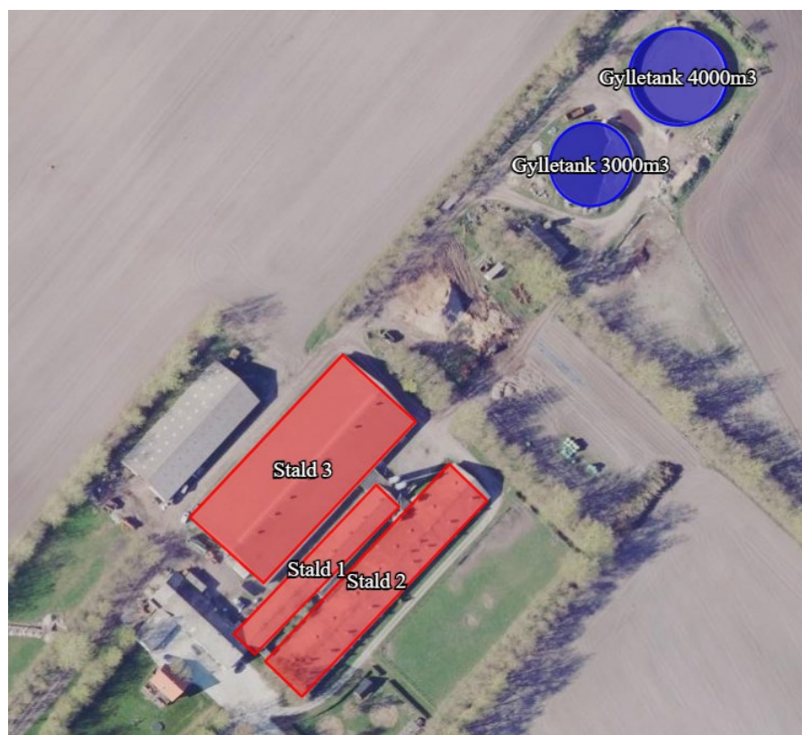
Figur 1 Oversigt over staldanlæg og gødningsopbevaring.
