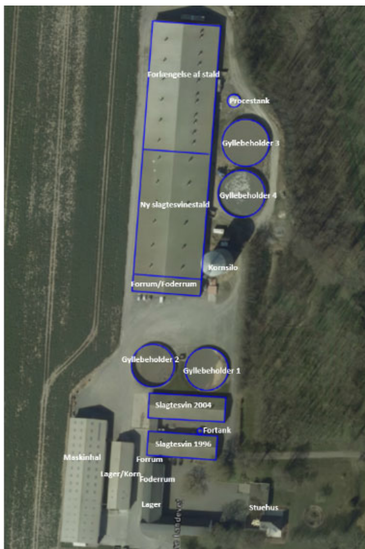
Figur 1 Eksisterende og ansøgte bygningsanlæg på Brogaard.
