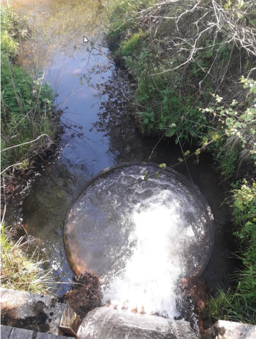
Figur 2: Det nuværende udløb fra leverdammene
