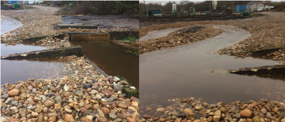
Figur 1: Venstre: Billedet viser afgitringen ved dambrugets vandindtag. Højre: Billedet viser omløbsstryget, der blev etableret i efteråret 2017.
