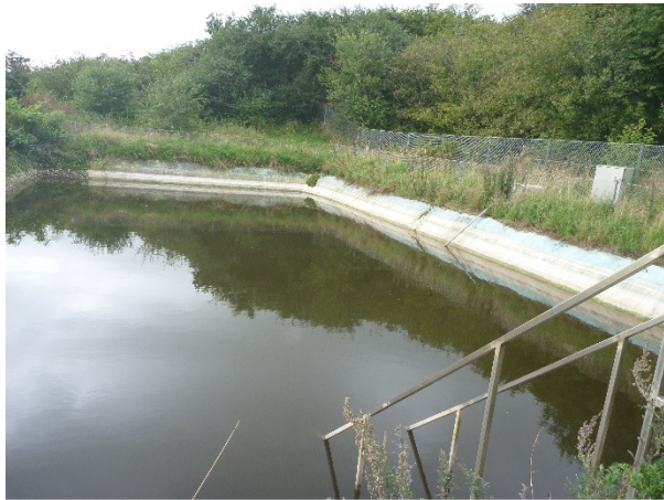
Fig. 3 Vandstanden i perkolatbassinet er faldet en smule efter ca. 1 time
