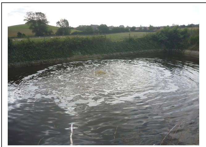
Fig. 2 Perkolat fra deponiet strømmer til perkolatbassinet efter pumpestart
