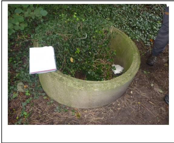
Fig. 6 Kun denne monitoringsboring (antages at være ”ny boring” eller ”boring 7”) blev lokaliseret på tilsynet
