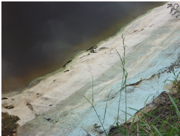
Fig. 4 Revner i perkolatbassinets membran
