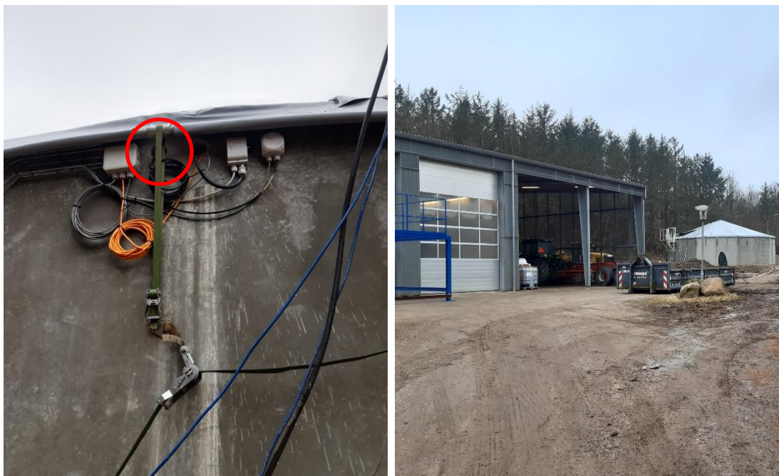
Figur 3. Andet spild. Tv: Det andet spild skete via et lille hul øverst på perkolattanken (markeret). Th: Perkolattanken er placeret nord for værkstedsbygningen. Spildet spredte sig begge veje om bygningen.
