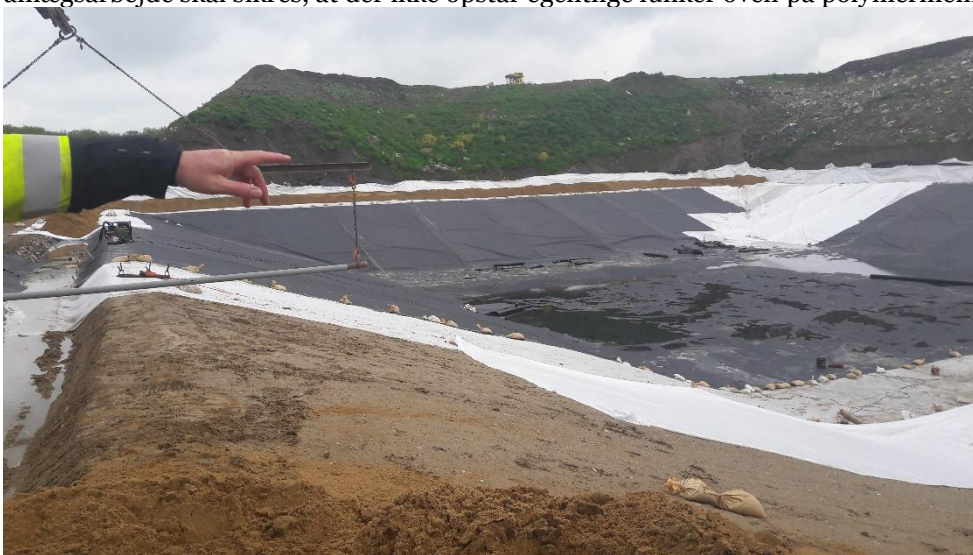
Figur 4: På den udlagte polymermembran kunne konstateres vandpytter fra nylig regnhændelse af ubetydelig karakter.
