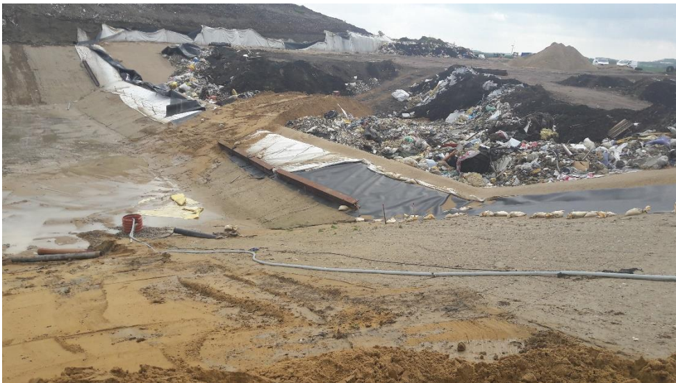
Figur 3: Vold imellem enhed 9 og enhed 10. Plastmembran er hen over vinteren fastholdt via spyd og jerndragere.
