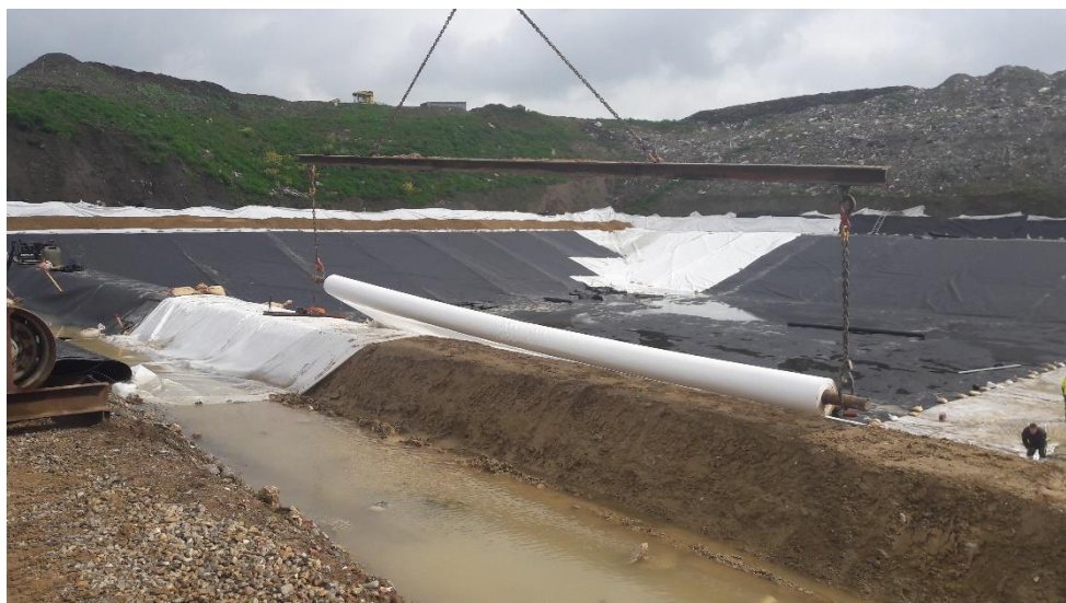
Figur 2: Udlagt polymermembran på den nordlige halvdel af enhed 9 set mod nordøst.
