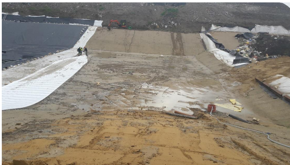
Figur 1: Overflade af lermembran på den sydlige halvdel af enhed 9 set mod øst.
