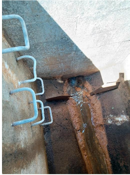
Billede 3 (venstre) Den vestlige skråning, hvorfra perkolat løber til grøften. (højre) Perkolatopsamling fra grøften.
