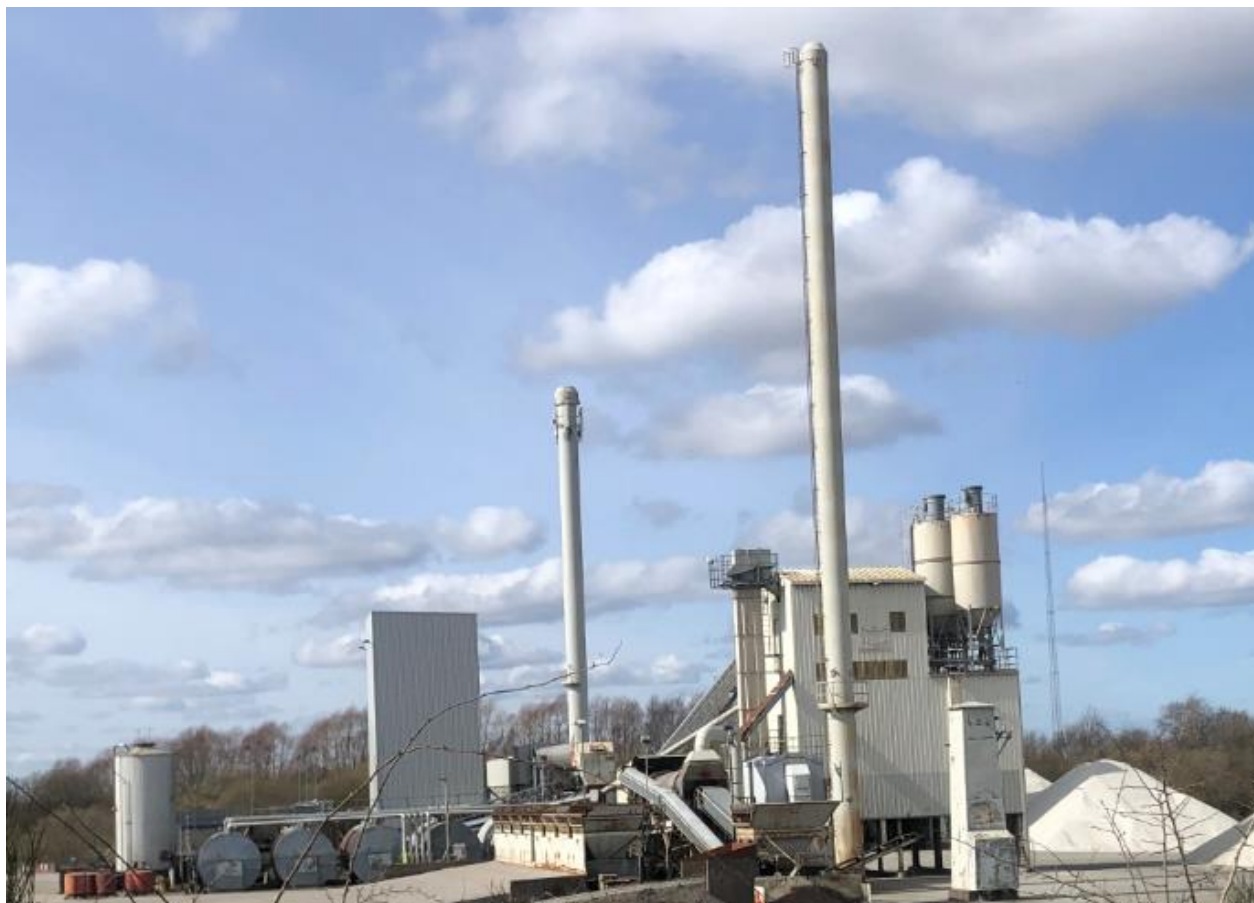
Billede 2. Produktionsanlæg 1 og 2 (Produktionsanlæg 2 er det forreste anlæg og er nedlagt). Til venstre på billedet kan der ses 5 tanke til bitumen i en tankgård. Virksomhedens tank til bitumenemulsion står udenfor tankgården (den høje tank til venstre).
