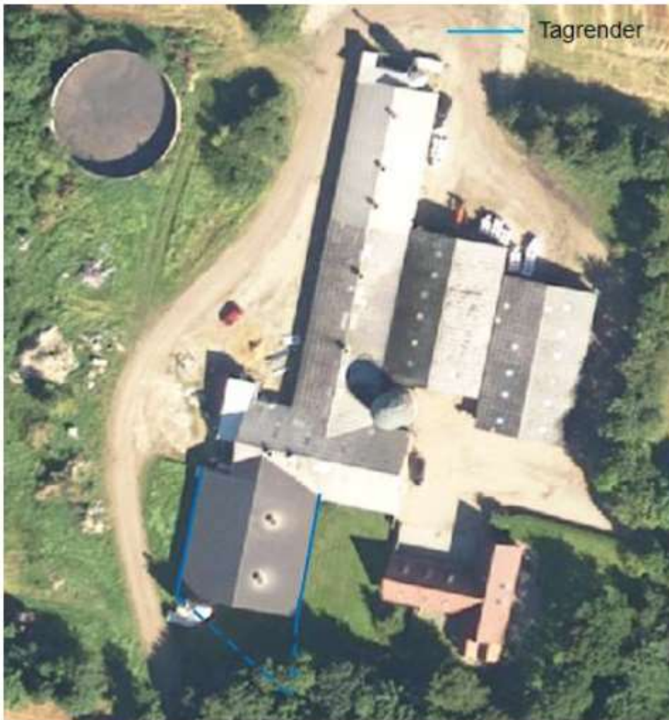
Aflledning af tagvand
