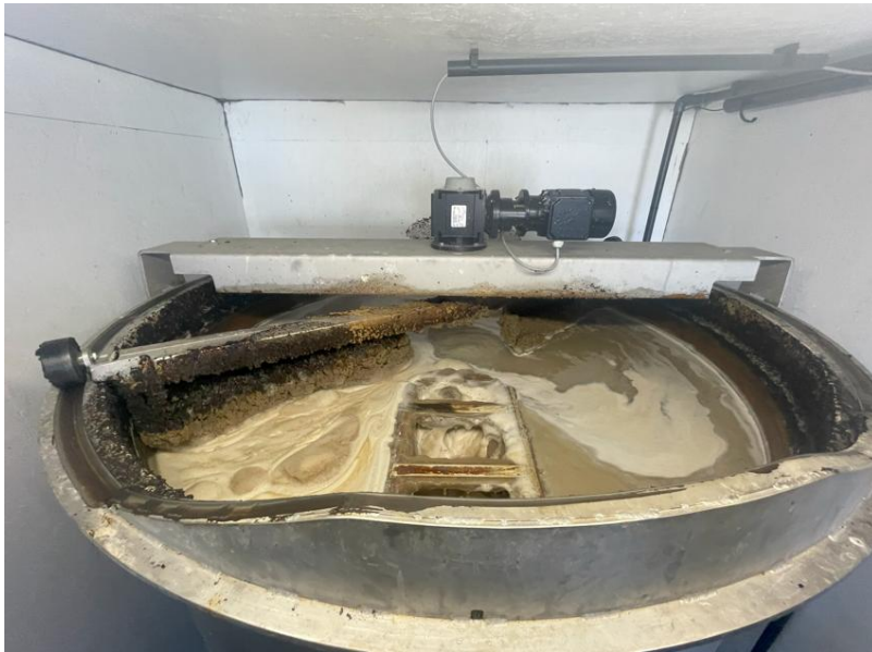
Skimmer i flotationstank som skimmer flokkuleret slam til presse.
