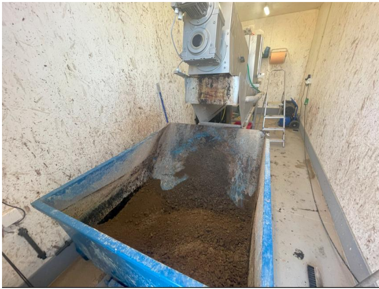
Slampresse som afvander slam fra flotationstank.
