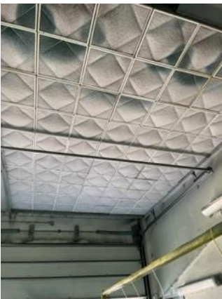
Figur 4: Top af sprøjtekabine med filtre.
