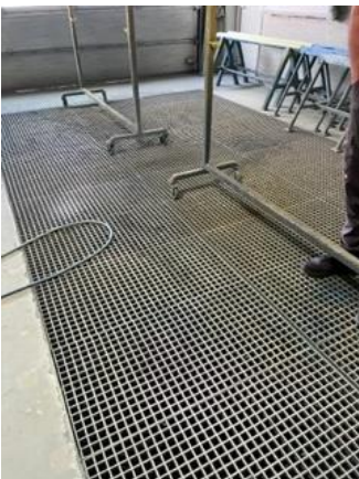
Figur 5: Bund af sprøjtekabine
