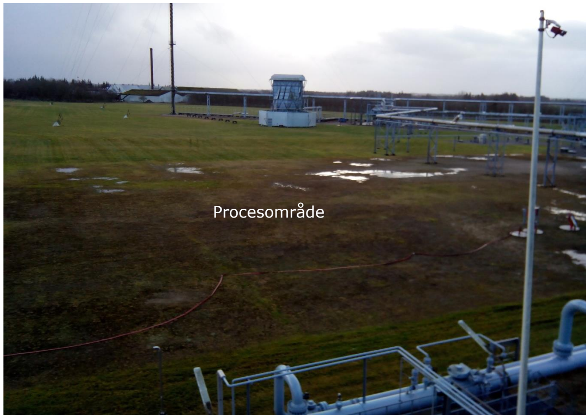
Figur 2-5 Areal for procesområdet. Bygningerne i baggrunden, mod Vest, er Nybro Tørreri og Nybro Omlastestation. I forgrunden ses lidt af Syd Arne terminalen.
