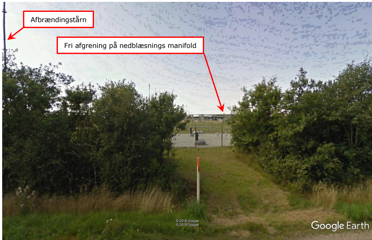
Figur 2-3 Procesanlægget vil være placeret under den på billedet viste stuts.
