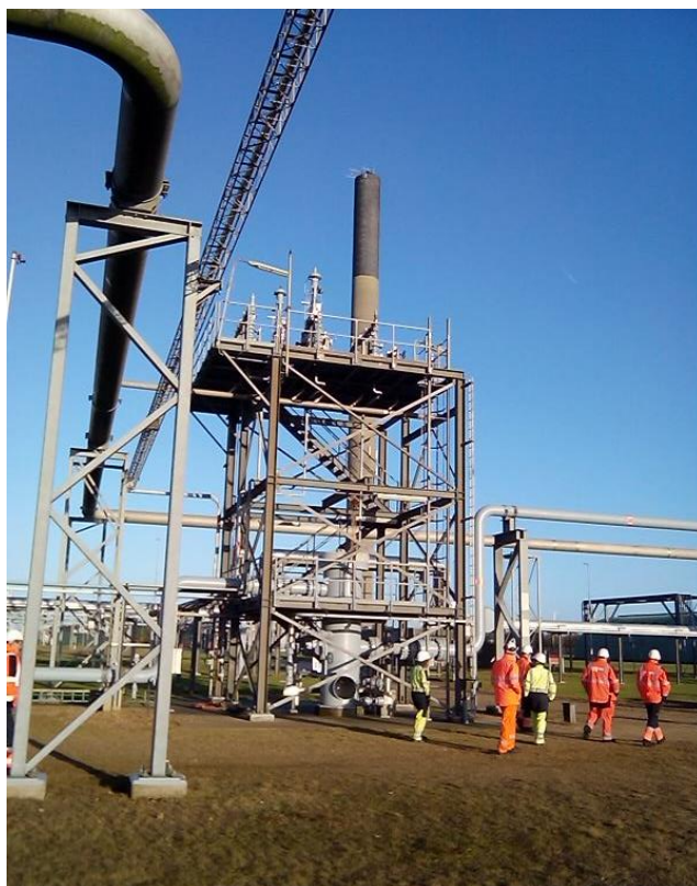
Figur 2-8 Struktur omkring filter på Syd Arne terminalen
