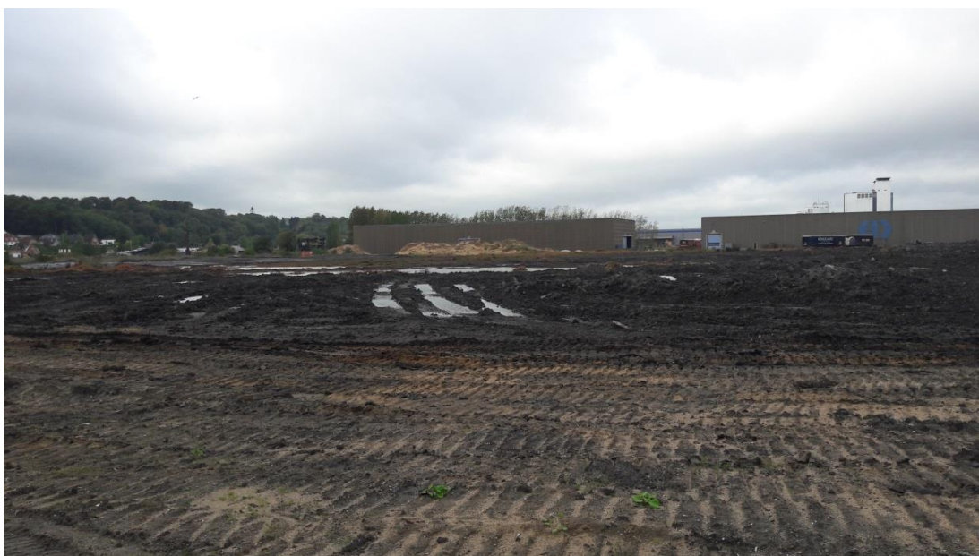
Foto 3: Deponeringsanlæggets etape nord, som nu er opfyldt. Set fra etapens østlige afgrænsning i retning mod vest. Udjævning af området pågår.
