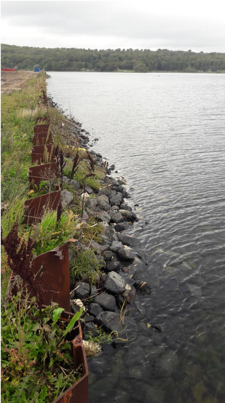
Foto 1: Deponeringsanlægget østlige afgrænsning, set i retning syd mod nord. Metalspunsvæg opført for at hindre udskridning. Ingen bundopskydning synlig.
