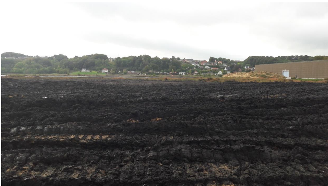
Foto 2: Deponeringsanlæggets nordlige bassin (etape nord), som nu er opfyldt. Set fra etapens nordlige afgrænsning i retning mod syd. Udjævning af området pågår.
