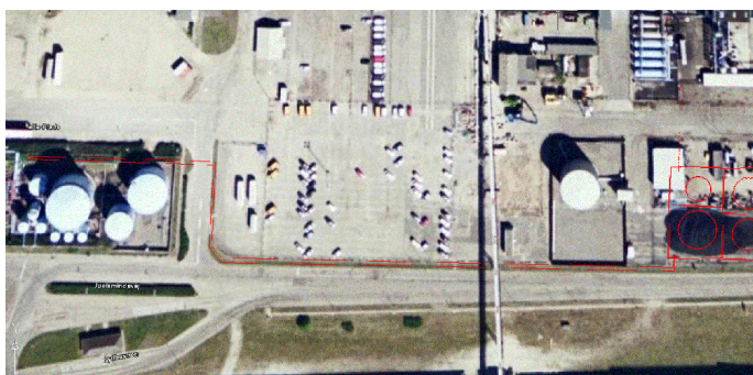
Figur 9.4.1 Rørføring på Juelsmindevej mellem KTT og tankanlægget.
