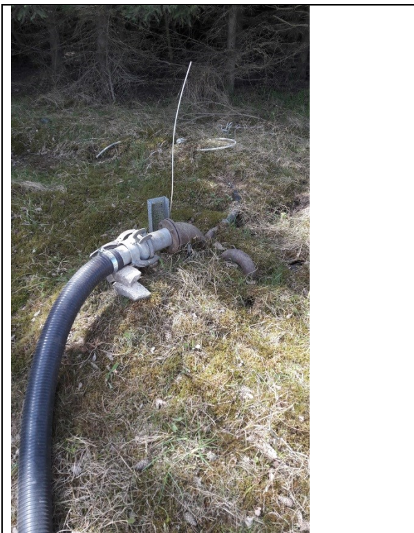
Perkolatbrønd 2, hvorfra perkolat bortkøres med slamsuger
