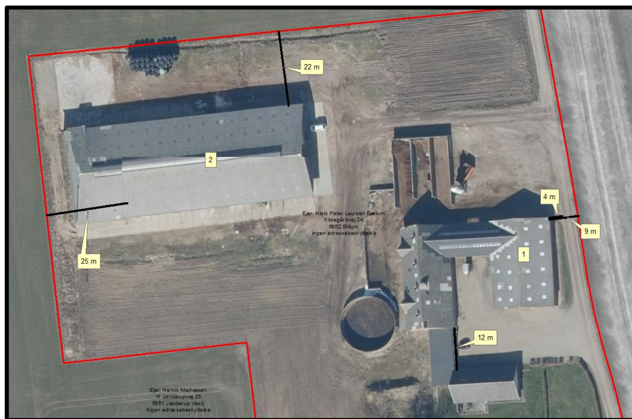
Figur 2. Manglende overholdelse af afstandskrav.
