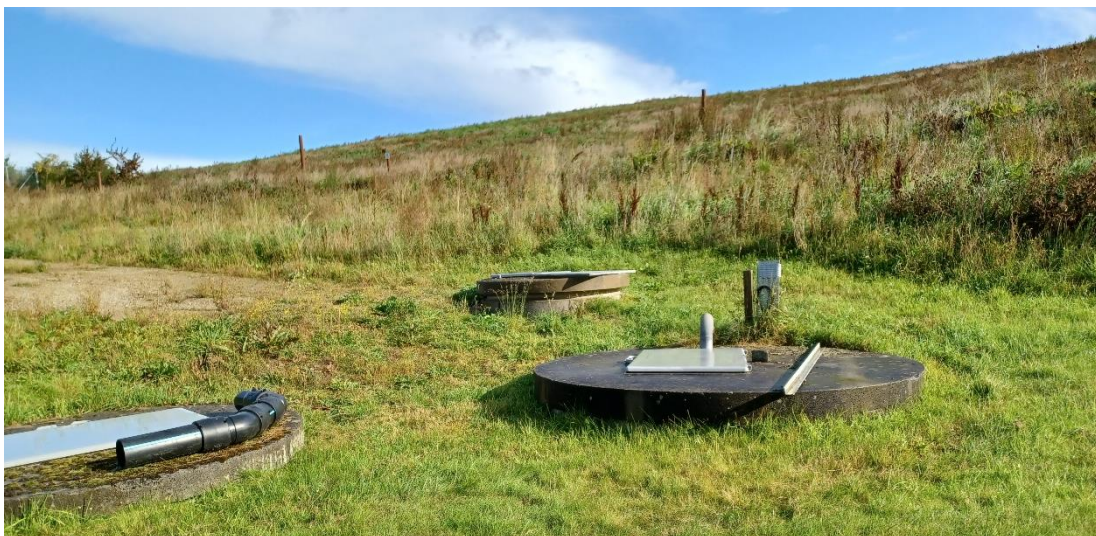
Figur 4. Adgangsvej og perkolatbrønde ved etape 5B. Øverst: Adgangsvej vest for etape 5B. Etape 5B ses til venstre og etape 5A bagerst til højre. Midterst: BT6 (til venstre). Betonklodser er opstillet for at forhindre påkørsel. Nederst: Samlebrønde for perkolat. Den bagerste brønd er blevet forhøjet 50 cm i forbindelse med udjævning af terrænet.
