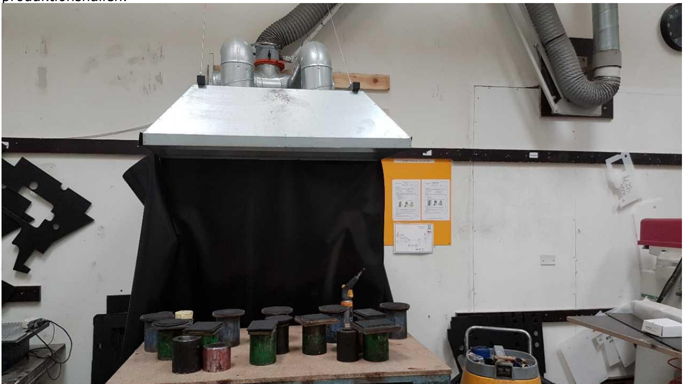
Punktudsug ved plads, hvor flossede kevlarøtråde brændes af.
