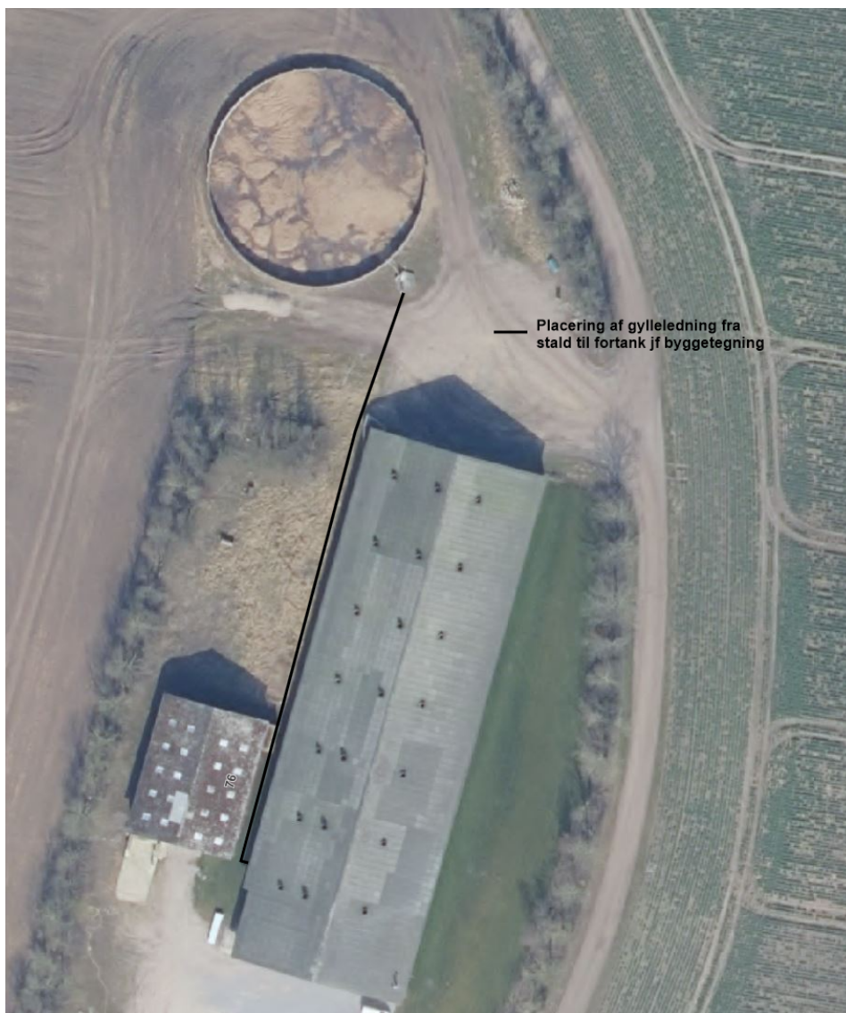
Rørføring af husdyrgødning og spildevand fra stald til lager.
