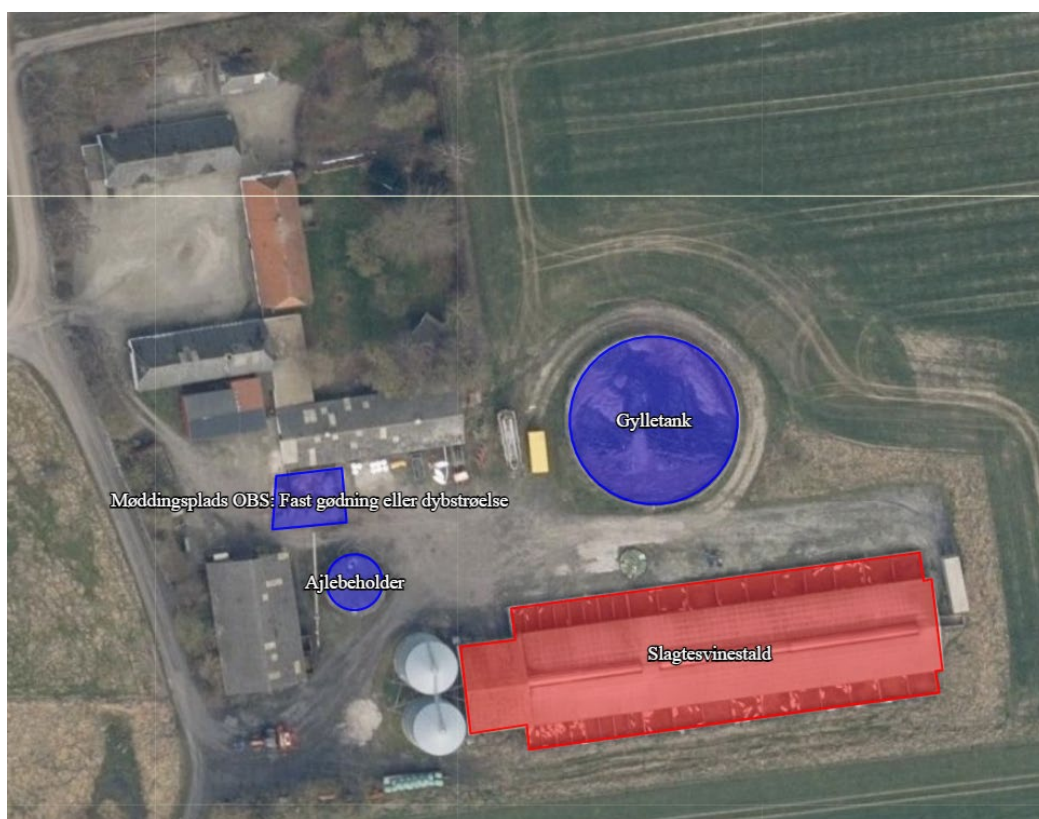
Figur 1: Oversigt over produktionsarealet på Noret 8, 5610 Assens.
