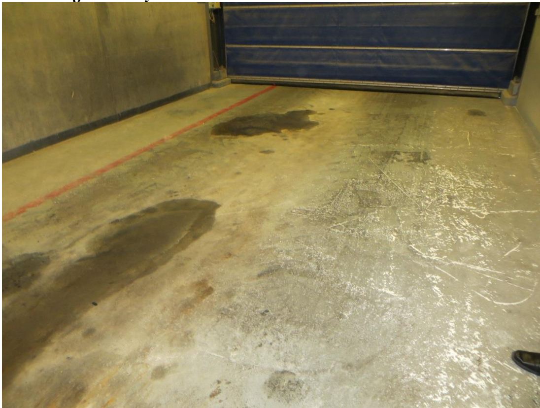
Belægning under pålæsning af flyveaske.
