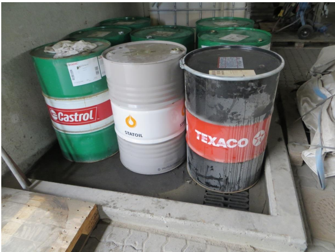
Olieaffald på betonbelægning med opkant og afløb i slaggehal. Afløb menes at løbe til olie- og benzinudskiller.
