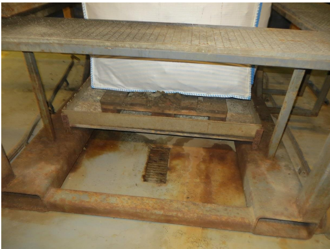
Filterkage fyldes i bigbags. Afløb i betongulv.
