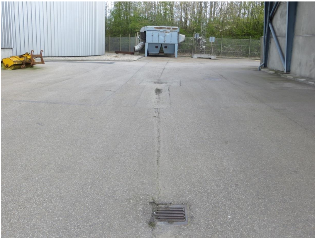
Kørselsareal med asfaltbelægning
