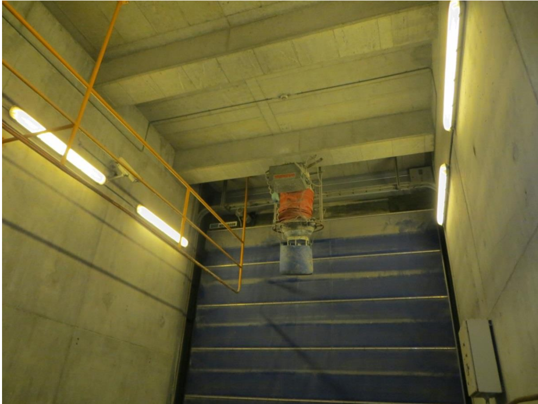
Pålæsningsslange sænkes ned i lastbil hvorefter flyveasken læsses.
