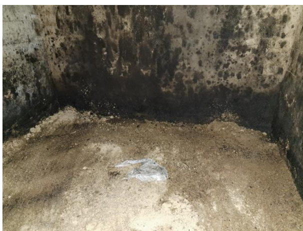
Figur 6. smøregrav tømt for spildolie og fyldt med opsugningsmateriale
