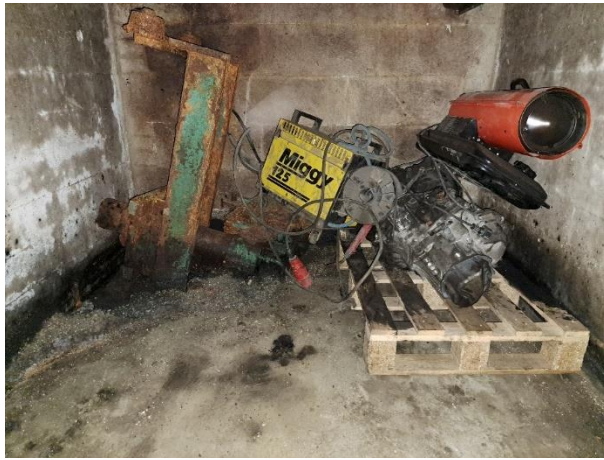
Figur 8. smøregrav tømt for spildolie og fyldt med opsugningsmateriale
