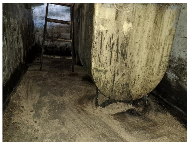
Figur 7. smøregrav tømt for spildolie og fyldt med opsugningsmateriale
