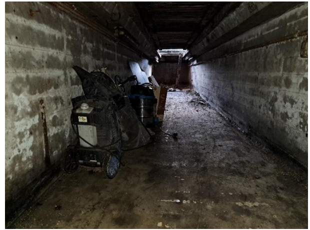
Figur 9. smøregrav tømt for spildolie og fyldt med opsugningsmateriale
