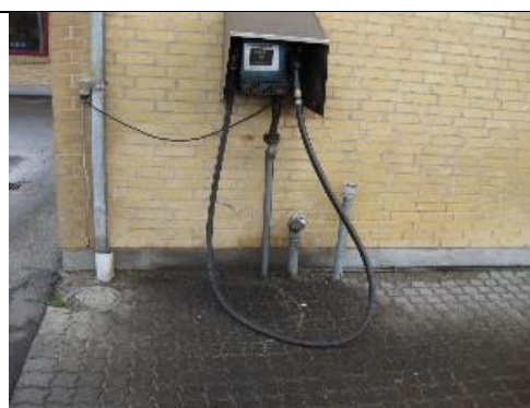
Udleveringsanlæg af dieselolie
