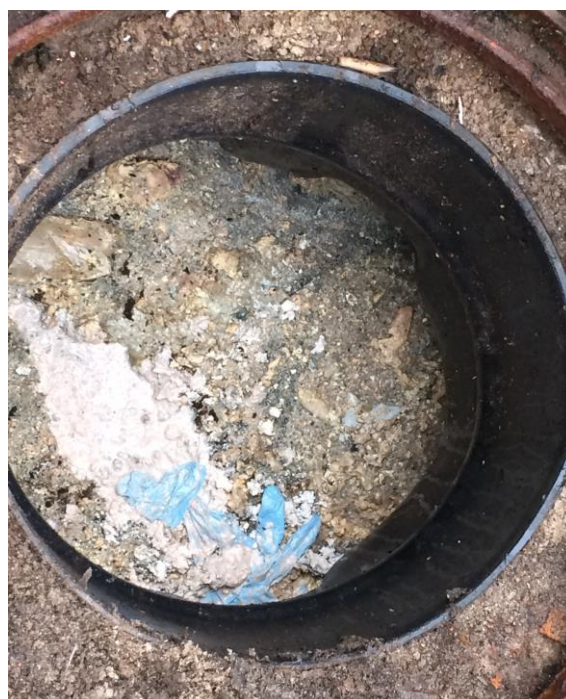
Billeder af fedtudskiller. I laget af fedt var der en gennemsigtig plasticpose og et par blå gummihandsker
