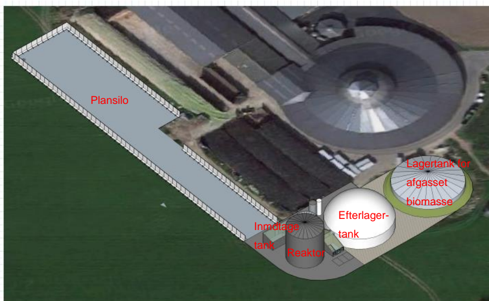
Indretning af biogasanlægget (mixtanken står bag ved reaktoren)
