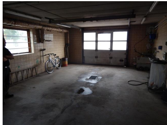
4. Vaskerum med afløb til olieudskiller.
