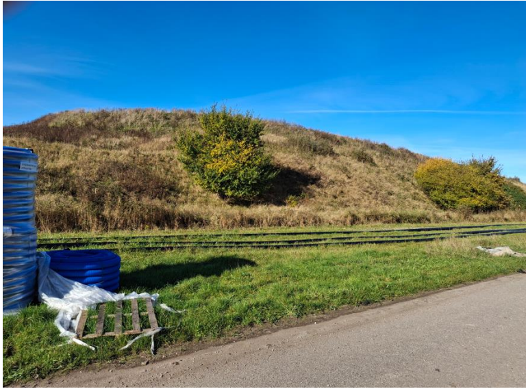
Billed 9. Oplag af ren jord til slutafdækning.
