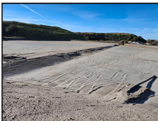
Billed 5. Kommende perkolatdræn (hoveddræn er ført gennem volden på nordlige celle.
