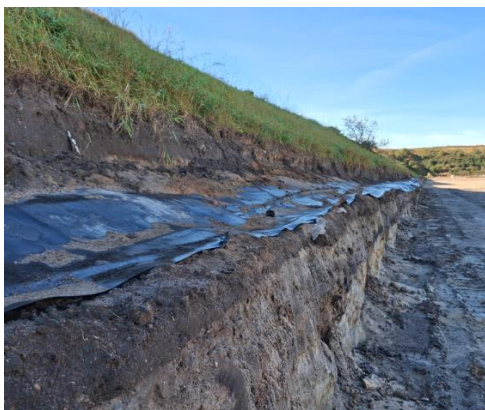
Billed 7. Fritlagt gammel membran på Enhed 1c.
