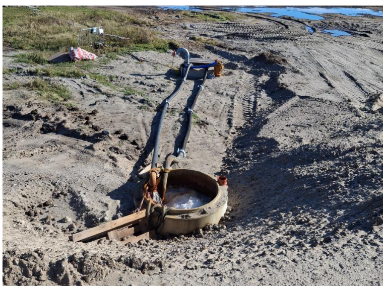
Billed 6. Grundvandssænkning. Grundvand ledes til den bageste brønd i billedet fra området under Enhed 3A. Herfra pumpes vand over i den forreste brønd og videre til grøftesystemet, hvor øvrig grundvand fra grundvandssænkning på hele anlægget også ledes til.
