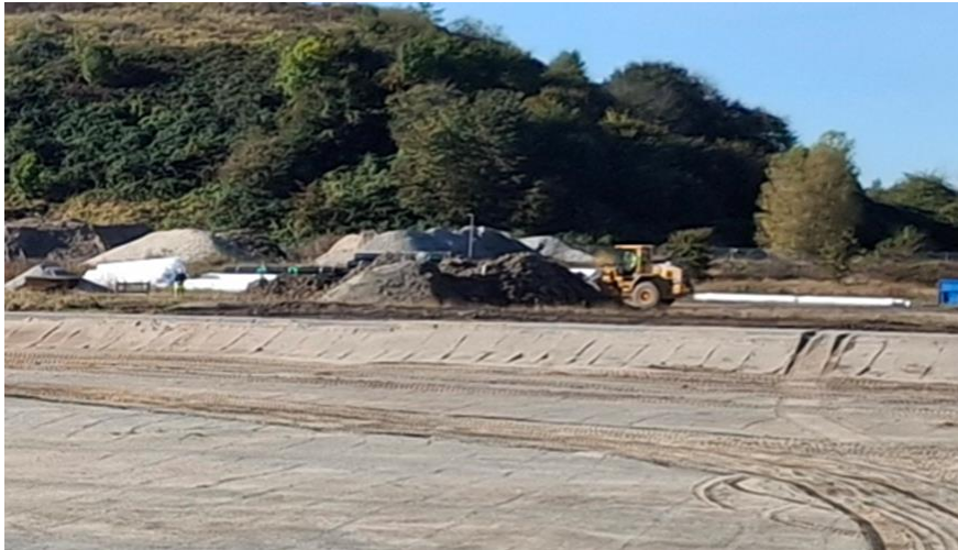
Billed 1. Bunker af ler til udlægning af membran.
