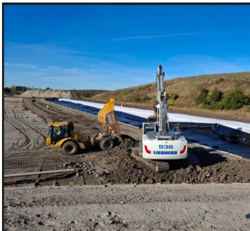
Billed 2. Udlægning af 2. lerlag på nordlige celle. Forrest i billedet ses en lille bunke af udtaget sten.
