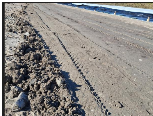
Billed 3. Komprimeret 1. lerlag på nordlige celle.
