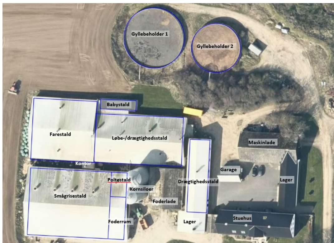
Figur 4 Anlægget på Stamperegård
