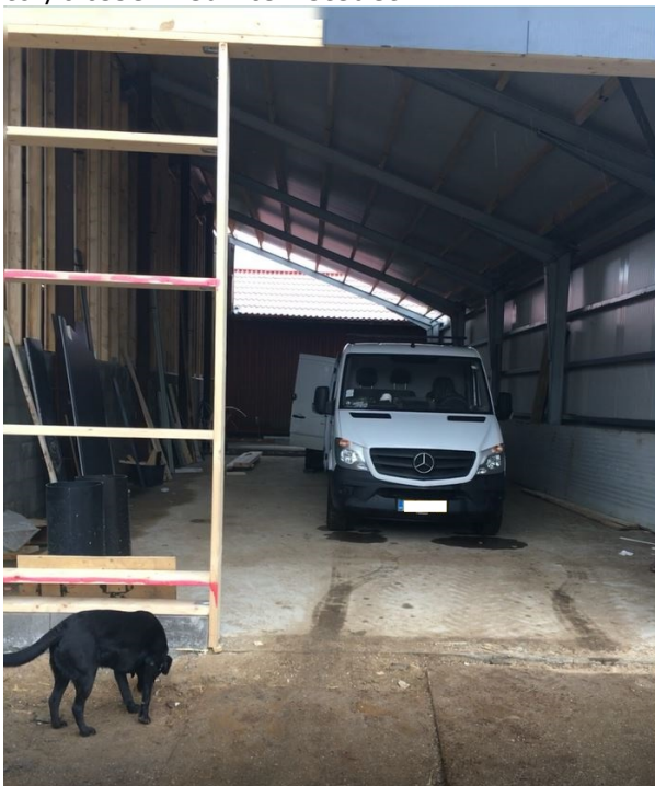
Ny bygning for nødgenerator og blæser
