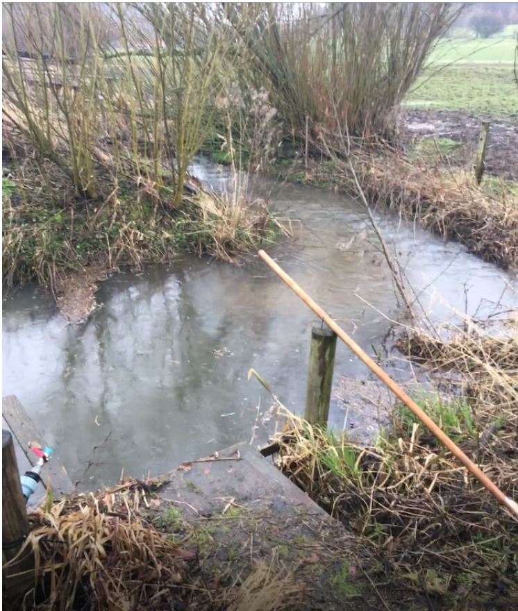
Indtagsbygværk ved Lammebæk samt afgitring
