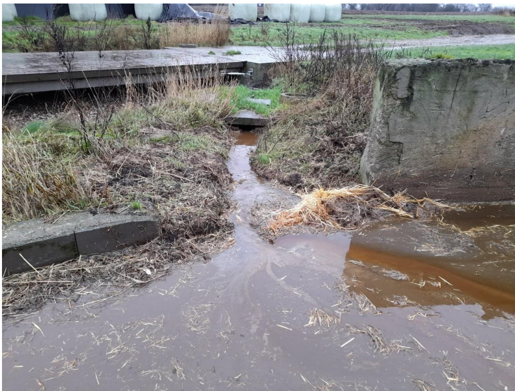
Billede 1. Afløb på vaskepladsen.
